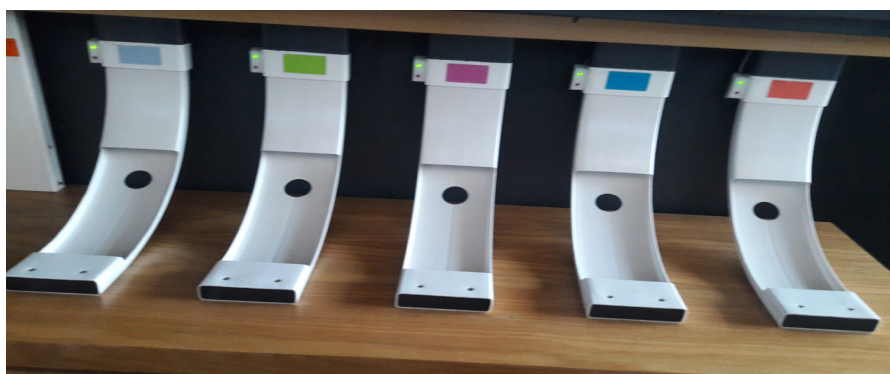
ورودی سیستم پنوماتیک برای انتقال مدارک از کارکنان به اپراتورها در تالار خدمات عمومی
